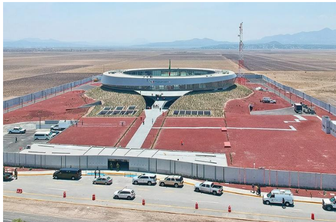
Ilustración 19. Instalaciones CHidalgo, México
